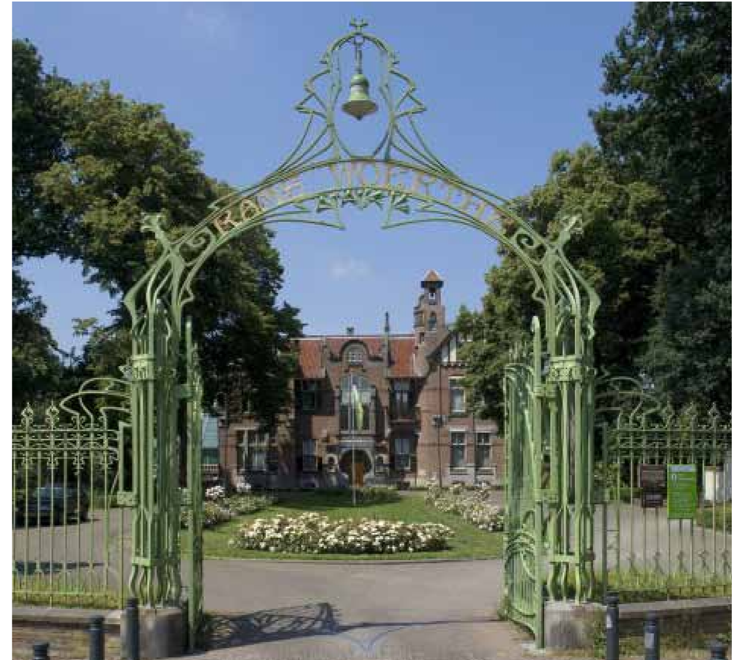
Villa Rams Woerthe in Steenwijk is het eerste Museumhuis van Vereniging Hendrick de Keyser.
